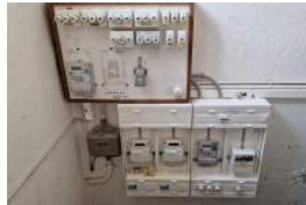
Déplacement et mise en conformité du tableau électrique
