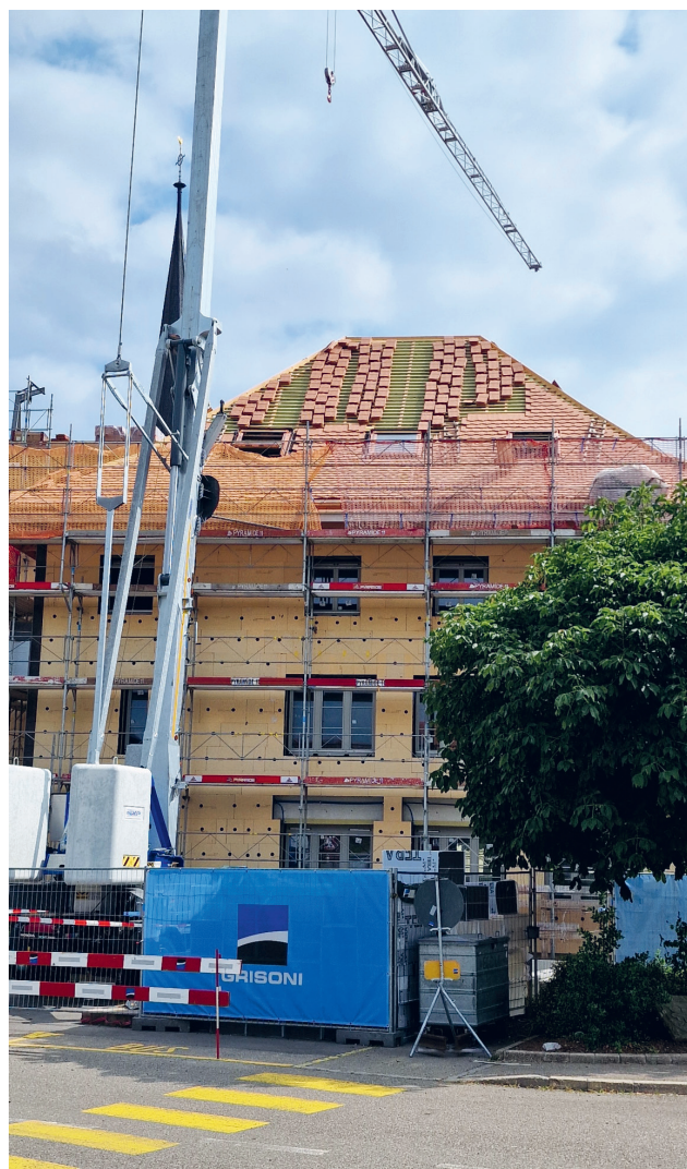
Pose de nouvelles tuiles pour le toit, pose de l'isolation périphérique (juillet 2025)
