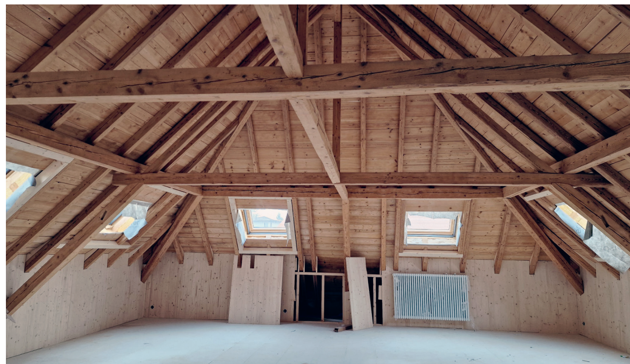
Sablage de la charpente réalisé, pose des Vélux pour la salle des combles, reste plus que les sols et l'éclairage.
