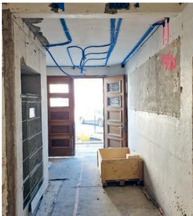
Mars 2025, enlèvement tuiles du toit et début de la pose des tubes d'alimentations électriques.
