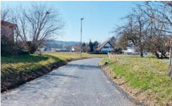
Le revêtement bitumineux de la route a dû être remplacé au vu des nombreuses fouilles déjà effectuées. Le solde des travaux d'enrobé est à réaliser encore au printemps.
